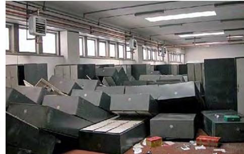
Fig. 2.22.7, 2.21.8 et 2.22.9 &gt; Dégâts malgré des étagères intactes
