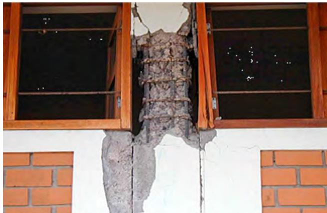
Fig. 2.4.2 > Rupture par cisaillement dans un poteau court en présence d'un remplissage en maçonnerie
