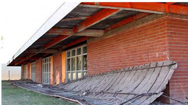
Fig. 2.10.3 et 2.10.4 > Décrochage de la sous-toiture et éclatements dans le crépi
