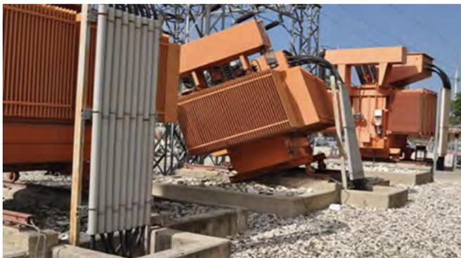
Fig. 2.14.1 &gt; Transformateurs haute tension renversés
