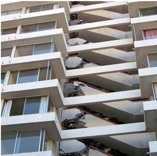
Fig. 2.7.1 et 2.7.2 &gt; Diagonales de compression dans une volée d'escaliers
