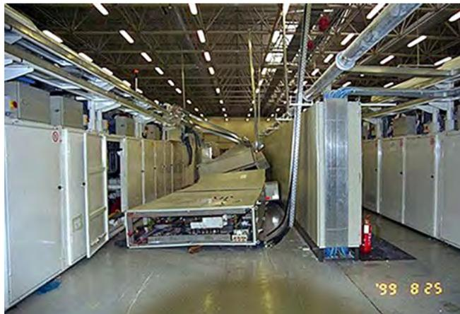
Fig. 2.13.1 et 2.13.2 &gt; Armoires de commande renversés
