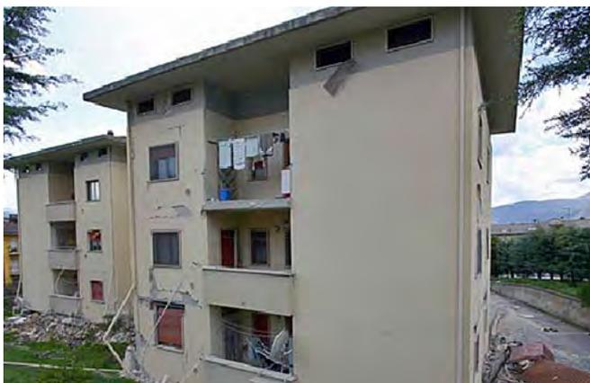
Fig. 2.6.3 > Chute du parapet de l'étage supérieur
