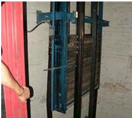
Fig. 2.19.1 > Rails de guidage déformés par des contrepoids
