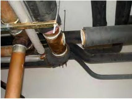
*un tuyau non fixé est rompu à l'endroit du raccord*
