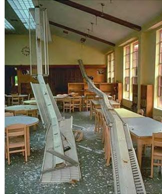
Fig. 2.15.1 et 2.15.2 > Chute d'éléments d'éclairage
