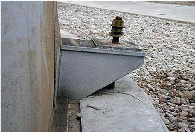
Fig. 2.17.3 &gt; Fixation endommagée
