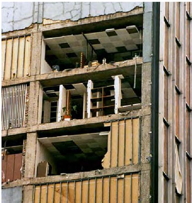
Fig. 2.5.3 > Rupture d'une façade suspendue
