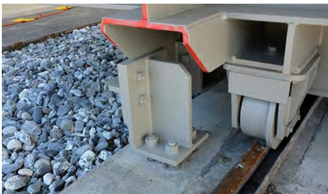
Fig. 2.14.3 &gt; Fixation d'un transformateur monté sur roues
