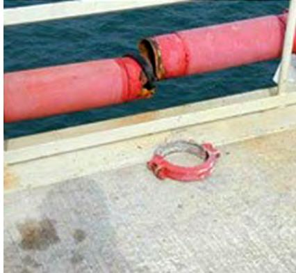
Fig. 2.18.6/2.18.7 &gt; Dommages à des passages à travers des murs
