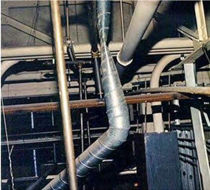
Fig. 2.18.1 &gt; Dégâts dus à des chocs
