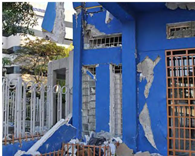
Fig. 2.8.3 > Dommages subis par un vitrage constitué de briques en verre
