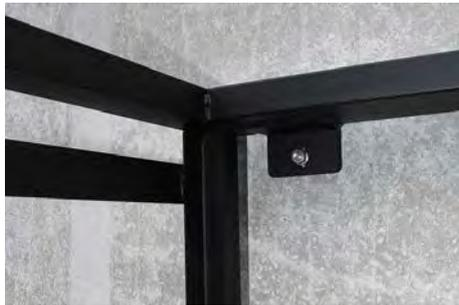
Fig. 2.3.7 > Fixation du châssis de base au mur
