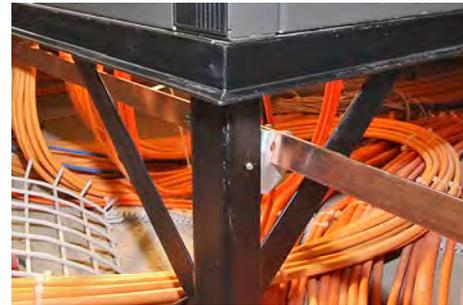
Fig. 2.3.8 > Stabilisation horizontale par barres diagonales
