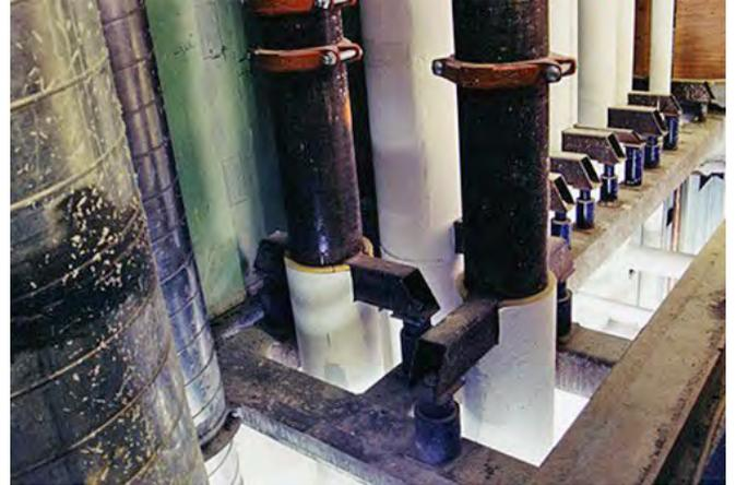
Fig. 2.18.11 > Appui de conduites verticales au passage de dalles
