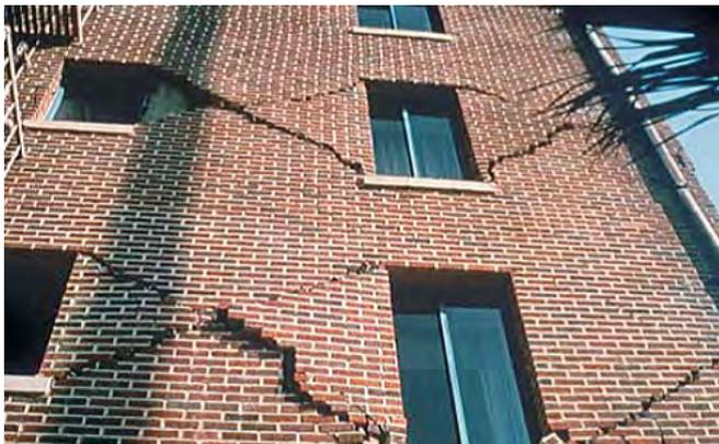
Fig. 2.5.1 > Fissures en croix entre fenêtres
