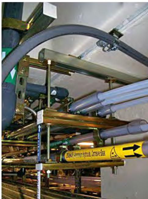
**Fig. 2.24.4** > Enveloppe de protection sur appui transversal, étiquetage de la substance transportée
