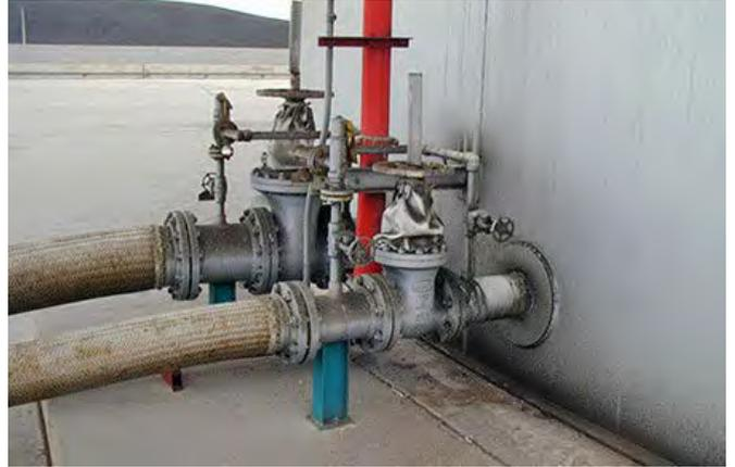
Fig. 2.17.6 > Raccords flexibles
