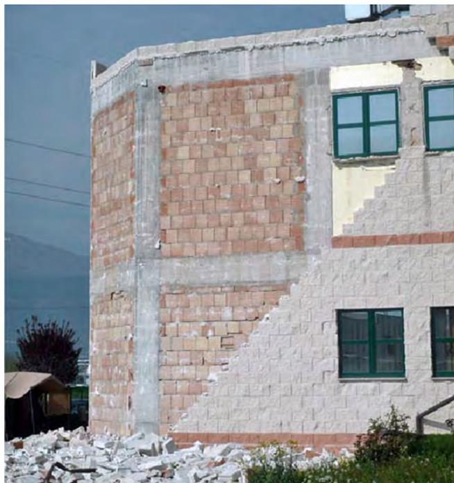
Fig. 2.5.4 > Chute d'une façade en maçonnerie préfabriquée
