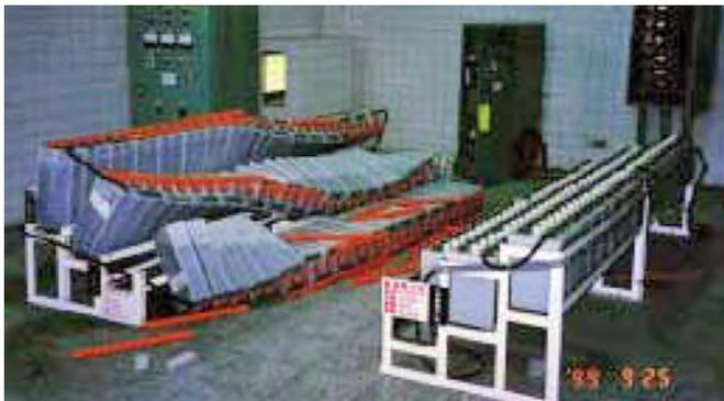
Fig. 2.11.1 > Dégâts subis par un châssis sur lequel étaient posées des batteries de secours et chute de celles-ci
