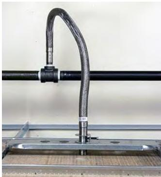
Fig. 2.12.3 > Raccord flexible à une conduite principale
