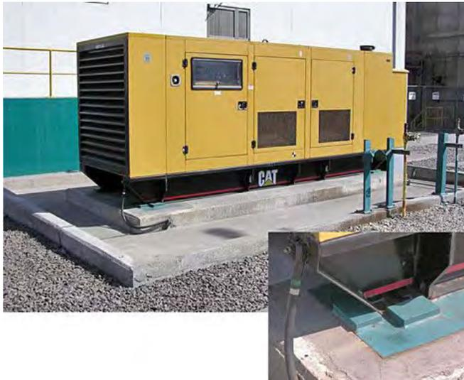
Fig. 2.16.7 > Butée horizontale bloquant un générateur
