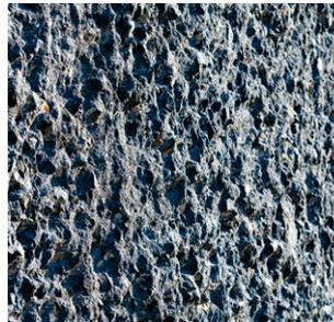
Figure 4 : Exemples de traitement par lavage ou à l'acide
