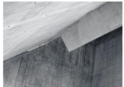
Figure 40 : Exemple de joint de reprise sur une paroi
