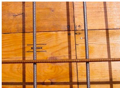
Figure 39 : Exemple de joints de peau de coffrage réguliers sur le plafond et la paroi ; bavures de mortier au joint de reprise entre ces deux éléments
