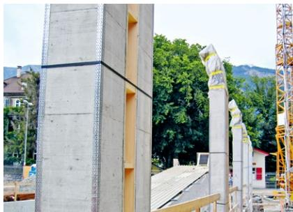
Figure 42 : Exemple de joints horizontaux
