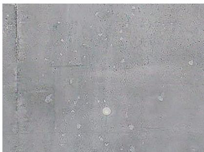
Figure 53 : Nid de gravier mastiqué au niveau du joint de coffrage
