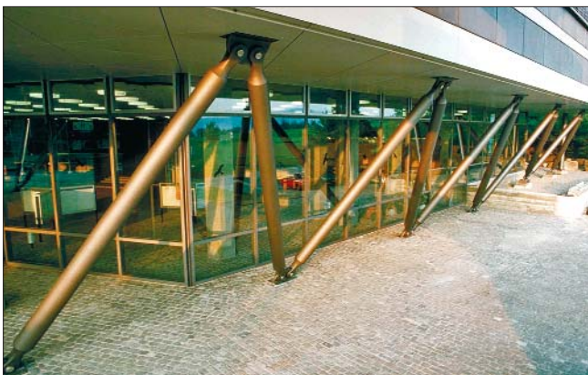
Bâtiment d'auditoires de l'EPF Zurich, avec le treillis apposé formé de colonnes en acier
