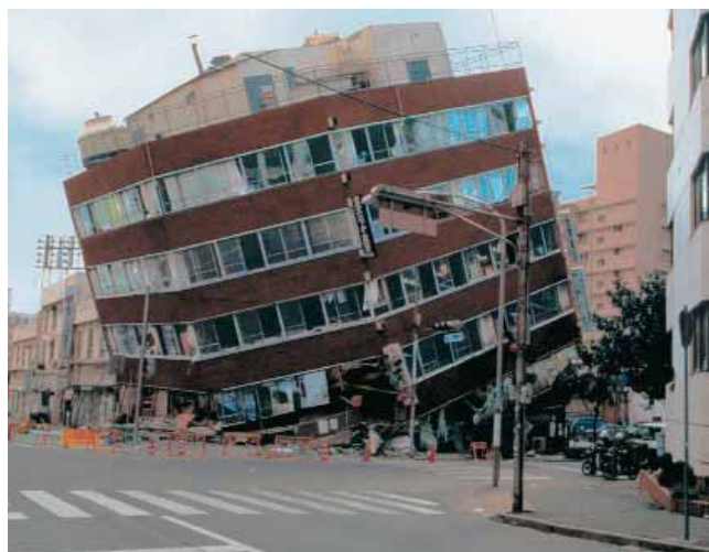
Bâtiment équipé d'un contreventement dissymétrique (Kobe, Japon, 1995) [5]
