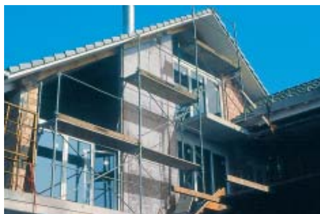
12/2 Cette nouvelle villa de trois étages, comprenant des parois porteuses en maçonnerie non-armée, est renforcée longitudinalement par une paroi porteuse en béton armé dans chaque façade et transversalement par un mur de refend disposé à l'intérieur du bâtiment (Suisse, 2001).
