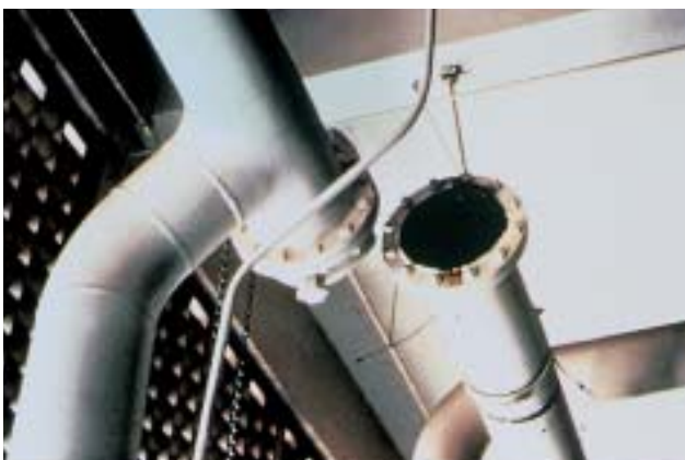
35/1 Les conduites – notamment celles de gros diamètre comme c'est le cas ici – sont très vulnérables si elles ne sont pas fixées solidement (San Fernando, Californie, 1971).
