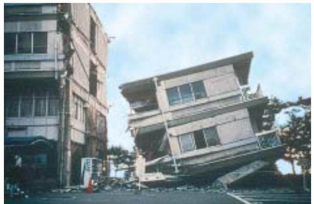
20/4 Le bâtiment effondré était une extension de l'immeuble plus ancien à gauche. L'ouverture des joints était insuffisante, ou alors les bâtiments n'étaient pas reliés assez solidement. L'ancien a heurté le nouveau lors du tremblement de terre, provoquant son effondrement (Kobe, Japon, 1995).
