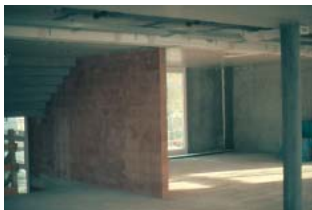
10/1 Il suffira d'un modeste tremblement de terre pour détruire la cage d'escalier porteuse, ce qui pourrait bien provoquer l'effondrement du bâtiment (Suisse, 2001).
