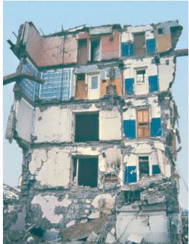
22/2 22/3 Les dalles de ces immeubles d'habitation se composaient également de panneaux préfabriqués insuffisamment reliés entre eux et avec les parois (Arménie, 1988).
