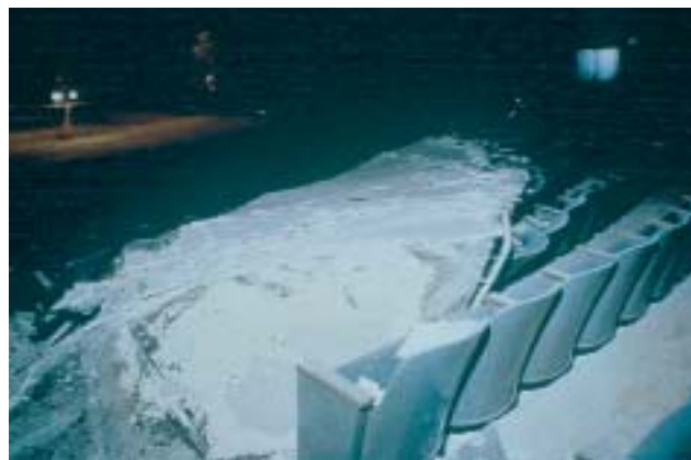
34/2 ... qui sont simplement suspendus à des fils métalliques de petit diamètre sont très dangereux pour les personnes (Northridge, Californie, 1994).
