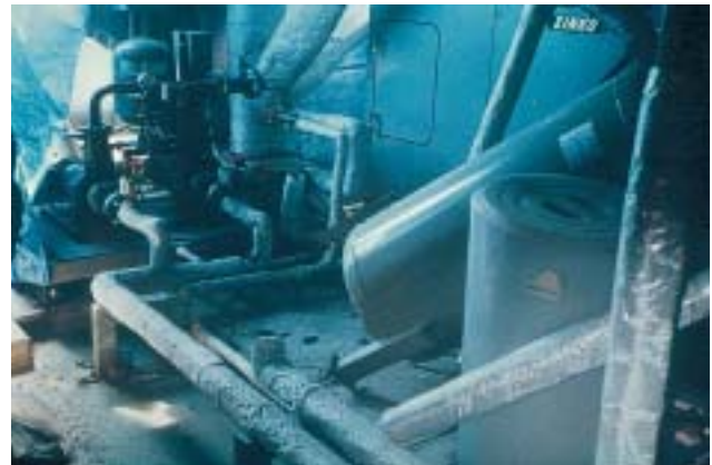
35/2 Les récipients et les machines risquent de se renverser s'ils ne sont pas ancrés suffisamment solidement (Kobe, Japon 1995).
