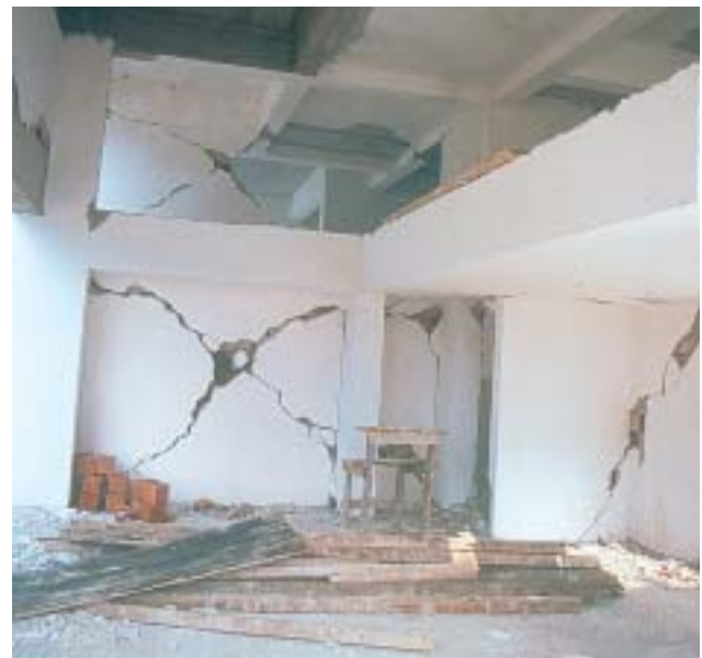
11/4 Ces fissures en croix sont caractéristiques des murs en maçonnerie remplissant des cadres massifs en béton armé (Izmit, Turquie, 1999).
