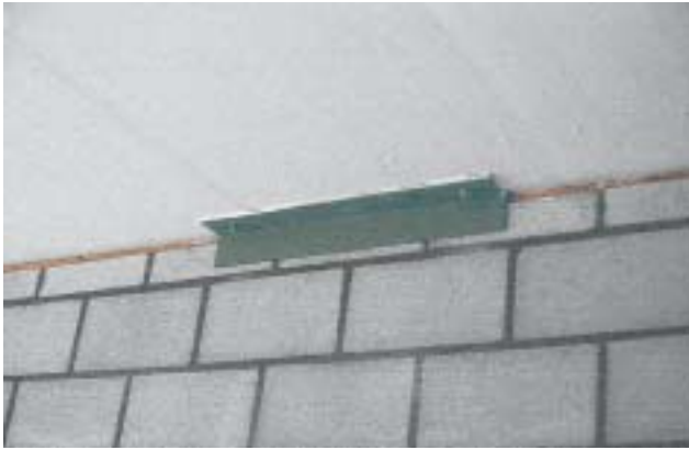
15/2 L'épaisseur des joints – ici entre une paroi en maçonnerie et un plafond – et les fixations des cornières (vis) doivent être adaptées aux déformations de la structure porteuse lors de sollicitations correspondant au degré de protection souhaité, c'est-à-dire à l'intensité du séisme pour lequel apparaissent les premiers dégâts (Suisse, 1994).
