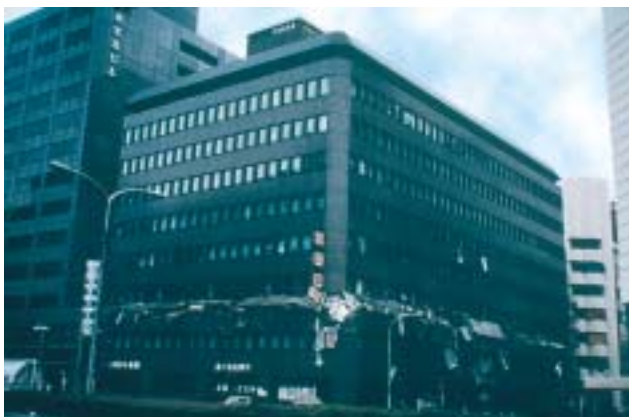
5/1 Le troisième étage de cet immeuble commercial a disparu. La partie supérieure s'est affaissée d'un étage (Kobe, Japon, 1995).
