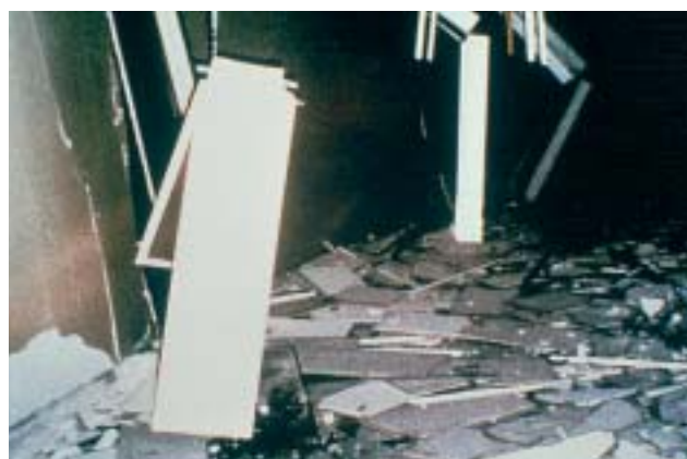
34/3 34/4 Des luminaires aussi mal fixés ou simplement accrochés au plafond risquent également de tomber et de blesser des personnes (San Fernando, Californie, 1971).
