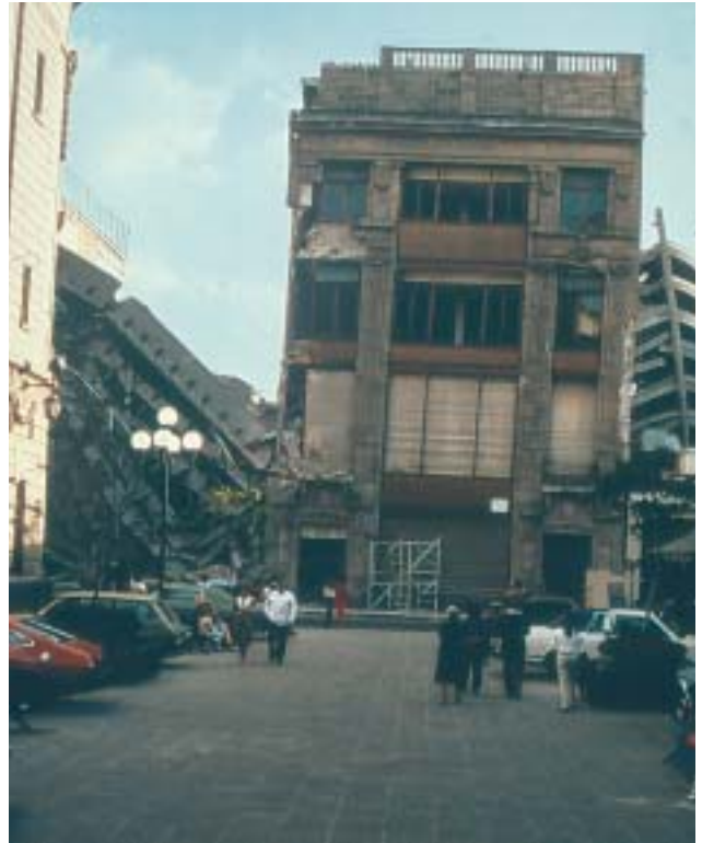
20/3 L'immeuble moderne, en béton armé à gauche, s'est effondré suite aux chocs avec l'ancien bâtiment très rigide à droite (Mexico 1985).
