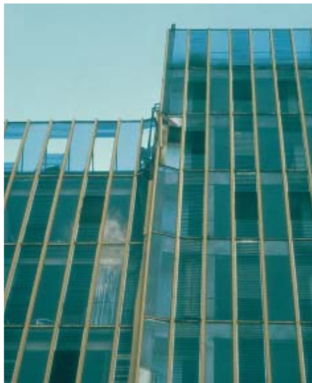
20/1 Dans ces deux bâtiments semblables et dont les dalles sont au même niveau, les chocs au niveau du joint ont notamment occasionné des dégâts aux façades et à la structure porteuse (Mexico, 1985).
