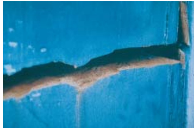
19/5 19/6 Dans un immeuble à structure en acier, une large fissure est apparue au pied de la colonne d'un cadre principal (à droite de la figure supérieure). D'importantes forces normales cycliques, la vitesse de charge, des défauts dans les matériaux, des soudures défectueuses et les effets thermiques figurent parmi les causes possibles (Kobe, Japon, 1995).
