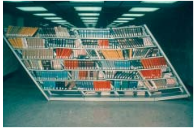
35/6 Les livres représentent une telle masse qu'il faut ancrer solidement les étagères et les contreventer dans les deux directions principales (Whittier Narrows, 1987).
