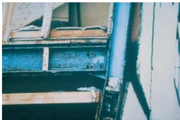
19/2 Ici, les boulons se sont cassés à la liaison entre la colonne et la poutre (Kobe, Japon, 1995).
