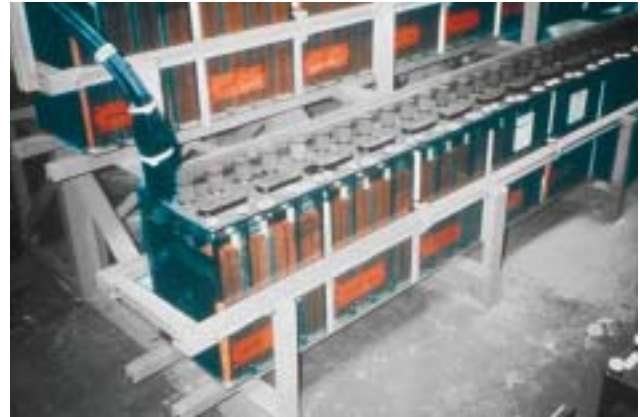
35/7 Bien fixés, les groupes de batteries et les groupes électrogènes de secours sont capables de fournir de l'électricité même après un tremblement de terre de forte intensité (Californie, 1980).
