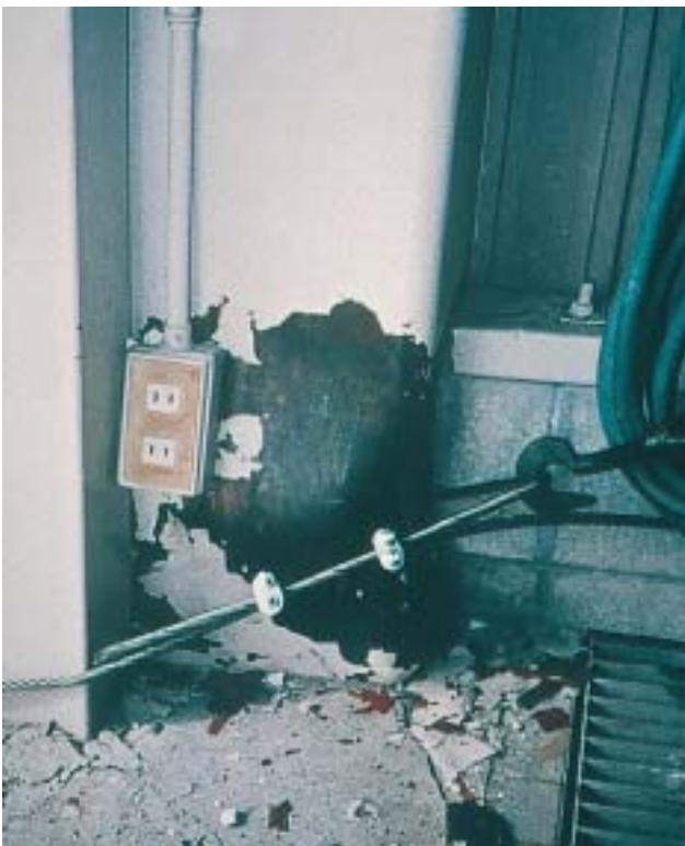
19/4 Le pied de la colonne (section rectangulaire) de ce cadre à trois étages s'est voilé localement et la peinture blanche le recouvrant a éclaté. (Kobe, Japon, 1995).
