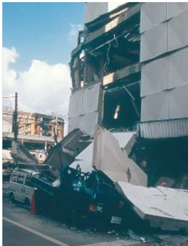
32/1 La structure porteuse de ce bâtiment ne s'est pas effondrée, mais des panneaux de façade insuffisamment ancrés se sont écrasés au sol (Kobe, Japon, 1995).
