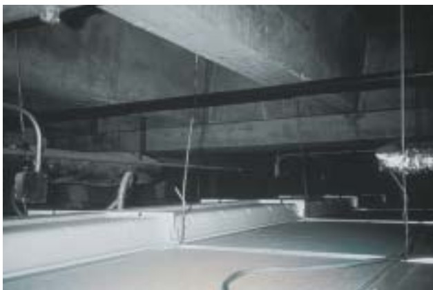
34/1 Des faux-plafonds et des revêtements de plafond ...
