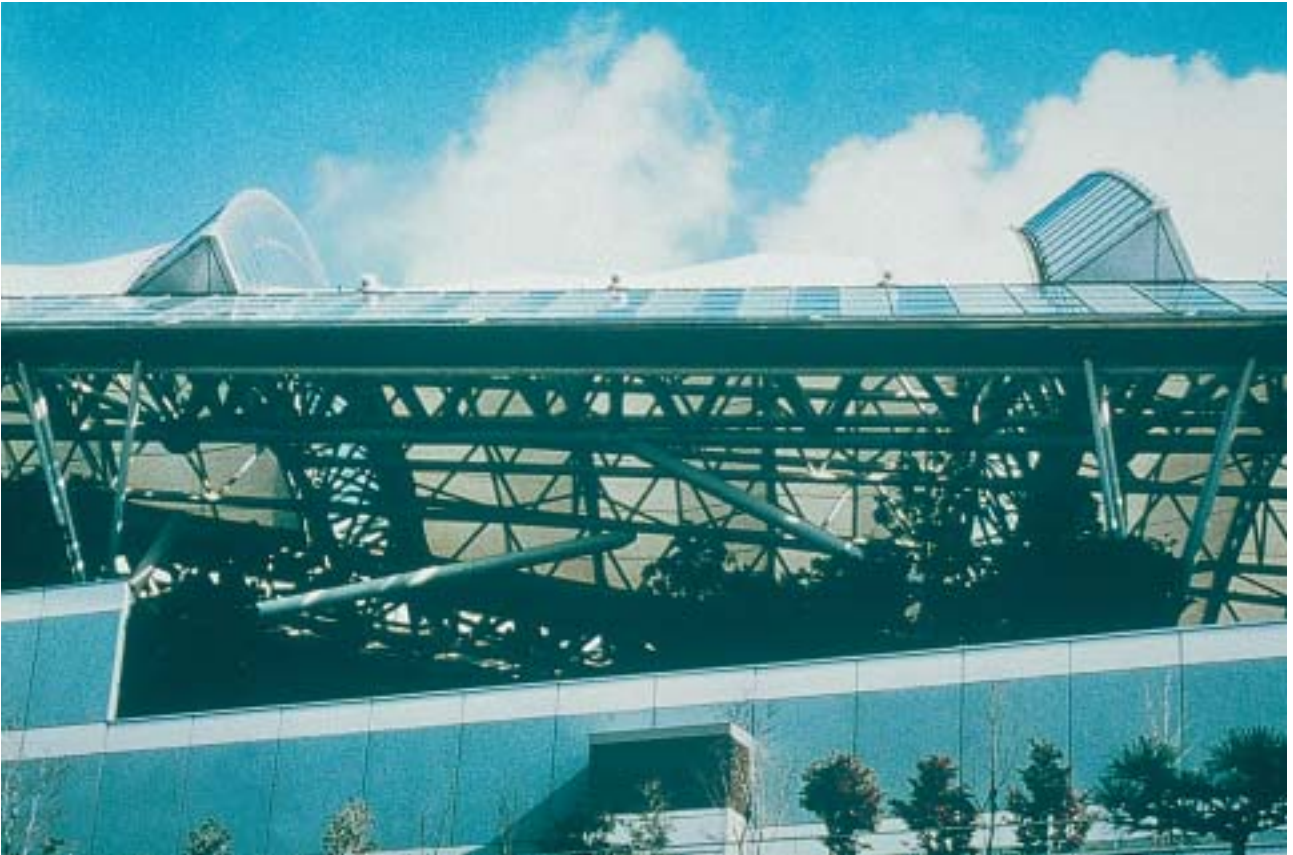
18/3 Dans cette structure porteuse en treillis, les défaillances des barres ont engendré une instabilité générale des piliers ainsi que des dégâts en de nombreux endroits (Kobe, Japon, 1995).
