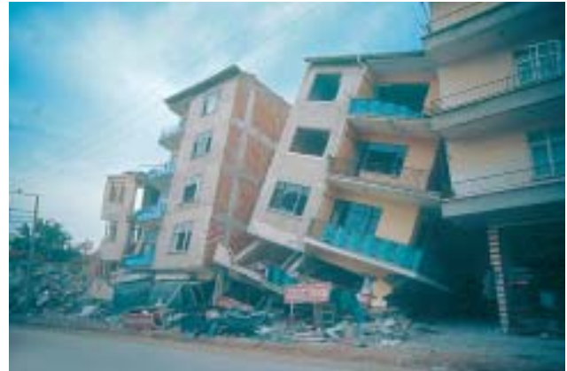
4/2 Les mécanismes de colonnes sont souvent inévitables lorsque le rez-de-chaussée est flexible (Izmit, Turquie, 1999).
