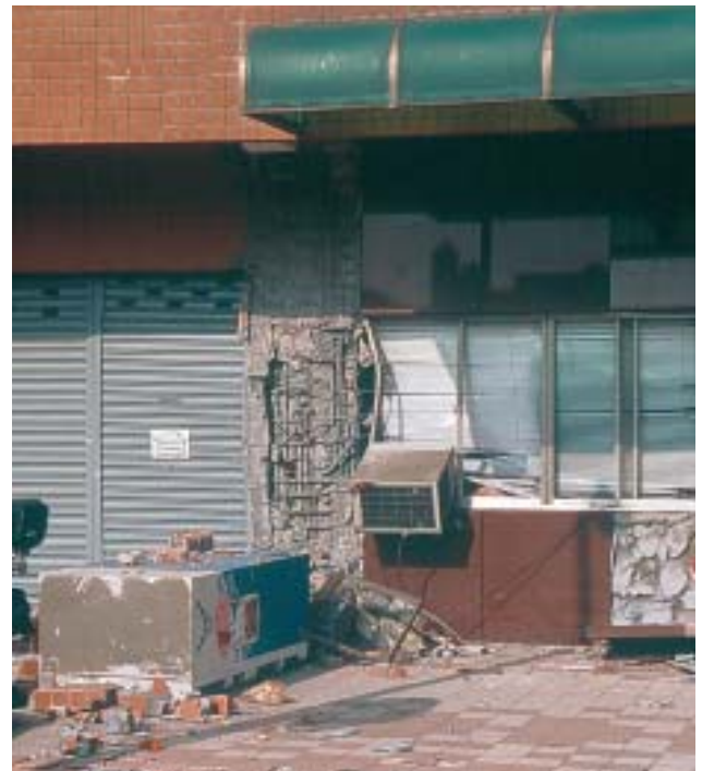
4/8 ... grâce à ses colonnes massives et à la bonne exécution de ses armatures de stabilisation et de frettage (Taiwan, 1999).
