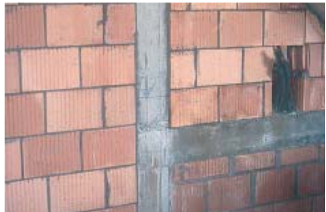
12/5 C'est pourquoi, il convient de remplir entièrement de mortier les joints séparant les parois porteuses en maçonnerie et en béton armé (Suisse, 2001).
