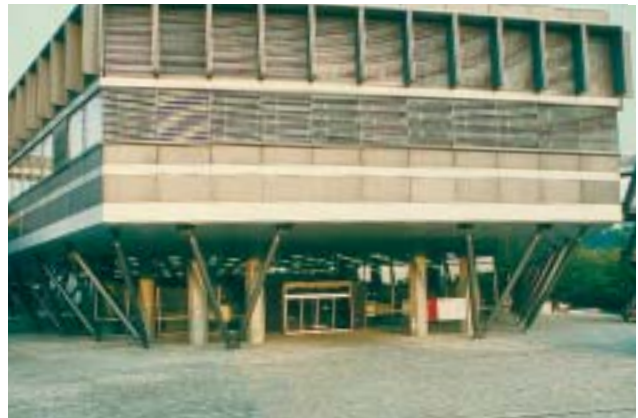
6/5 A l'origine, ce bâtiment d'auditoires construit au cours des années 1970 dans le campus du Höggerberg de l'EPF Zurich ne comprenait qu'un seul contreventement pour reprendre les efforts et déplacements horizontaux. Il s'agit de parois en béton armé de faible tenue à la torsion situées à l'extrémité arrière de l'ouvrage. Elles étaient tellement décalées par rapport au centre de masse que le séisme de référence, relativement faible (zone 1 d'aléa sismique selon SIA 160), aurait déjà provoqué une torsion significative du bâtiment dans le plan horizontal. Peu nombreuses et très chargées, les colonnes en béton armé du rez-de-chaussée auraient subi d'importants déplacements, notamment dans la partie antérieure de la construction. Or elles ne possédaient pas la ductilité requise. C'est pourquoi on a disposé sur trois côtés du bâtiment des colonnes obliques en acier formant un treillis conçu de telle façon que les forces horizontales agissant sur lui lors d'un tremblement de terre puissent être reprises sans difficulté par les fondations existantes. Cet assainissement a également permis d'améliorer la résistance contre les charges verticales en porte-à-faux.
