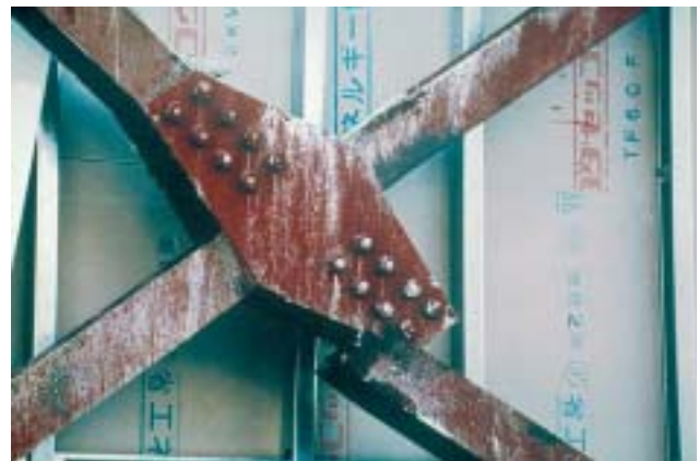
18/2 ...et se sont rompues (Kobe, Japon, 1995).
