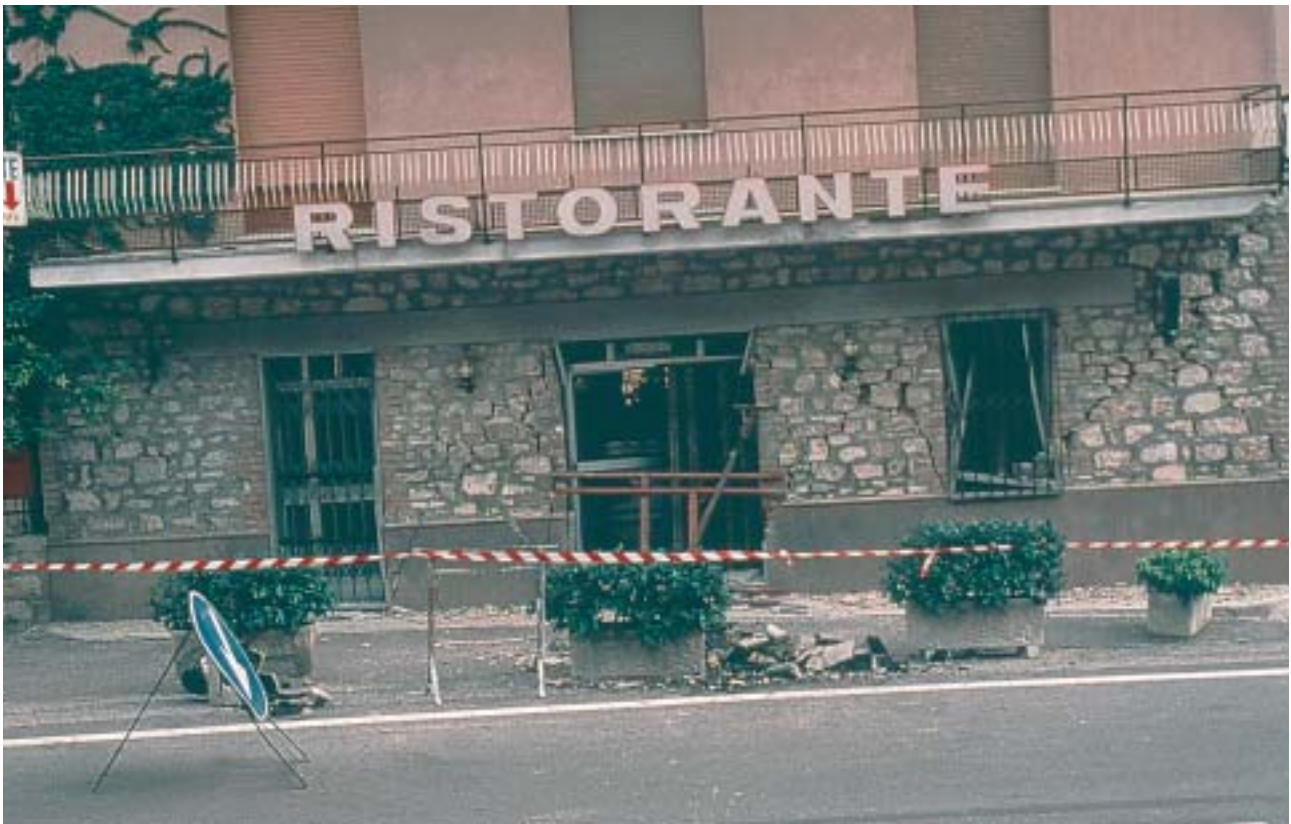
16/2 Les piliers en maçonnerie au rez-de-chaussée de ce restaurant ont fonctionné comme des colonnes courtes. Ils ont été gravement endommagés par des fissures obliques (Ombrie, Italie, 1997).
