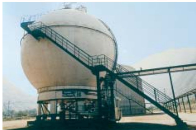
31/1 Ce réservoir de 700 t de gaz liquéfié, pourvu d'une structure porteuse en béton armé, a été posé sur des appuis sismiques flottants lors de son assainissement parasismique (Suisse, 1999).
