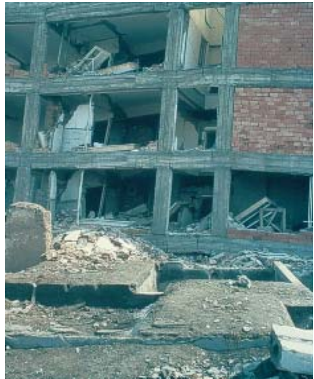
11/1 Ici, les colonnes étaient manifestement les plus résistantes. Une grande partie de la maçonnerie est tombée, mais le cadre a tenu (Erzincan, Turquie, 1992).
