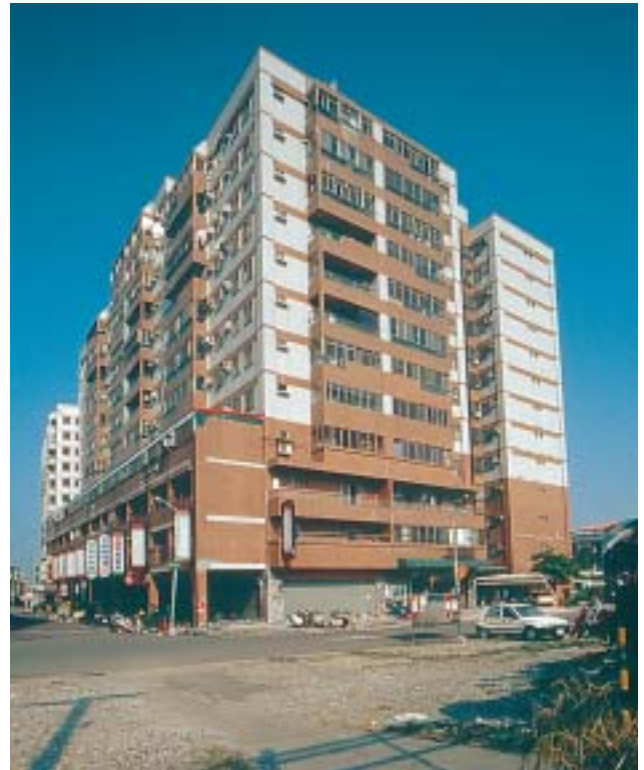
4/7 Ce grand bâtiment a évité de justesse de l'effondrement...
