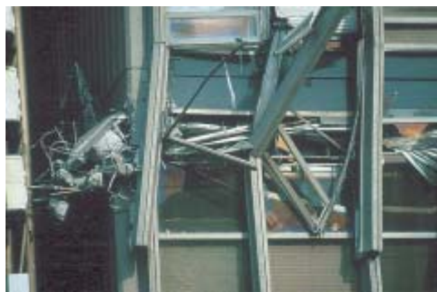
5/3 Cette vue rapprochée présente l'étage écrasé de l'immeuble de bureaux. (Kobe Japan 1995).
