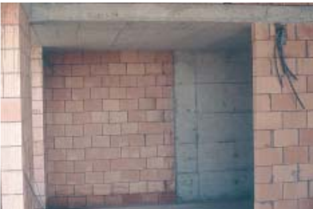
12/4 Les parois porteuses en maçonnerie et en béton armé ainsi que les dalles doivent être solidaires en compression et en cisaillement, et dans la mesure du possible en traction (Suisse, 2001).
