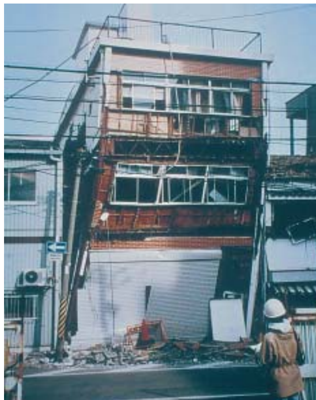
19/1 Ce cadre en acier a subi de grosses déformations permanentes. Selon toute vraisemblance, il n'y avait pas de contreventement et les liaisons entre colonnes et poutres ne tenaient pas suffisamment compte des sollicitations cycliques (Kobe, Japon, 1995).
