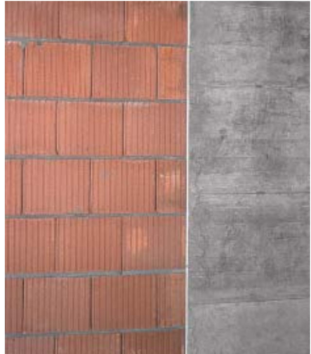
15/3 Ce joint, disposé entre une paroi en maçonnerie et une paroi porteuse en béton armé, est rempli par des plaques de mousse dure. Ce matériau est trop rigide pour les déplacements engendrés par les tremblements de terre. Le caoutchouc, par exemple, est préférable (Suisse, 1994).
