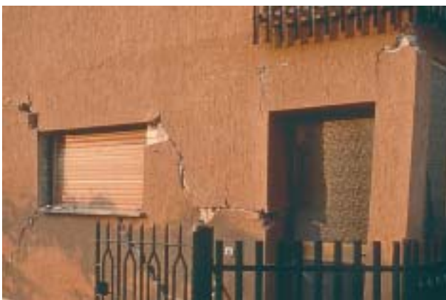
6/3 6/4 Cette maison d'habitation a été construite contre une maison similaire, dont elle partage un mur coupe-feu relativement solide et rigide. La façade antérieure est notablement plus souple, si bien que les centres de résistance et de rigidité sont décalés vers l'arrière. La maison a subi une forte torsion dans le plan horizontal, mais ne s'est de justesse pas effondrée (Ombrie, Italie, 1997).
