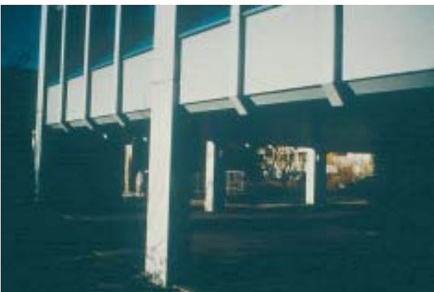
4/10 Pour ce bâtiment également, il est probable que les colonnes minces se trouvant sous les paraments soient trop faibles. Dans ce cas, une amélioration décisive pourrait être obtenue en ajoutant quelques parois porteuses de faible dimension horizontale en béton armé (Suisse, 1998).
