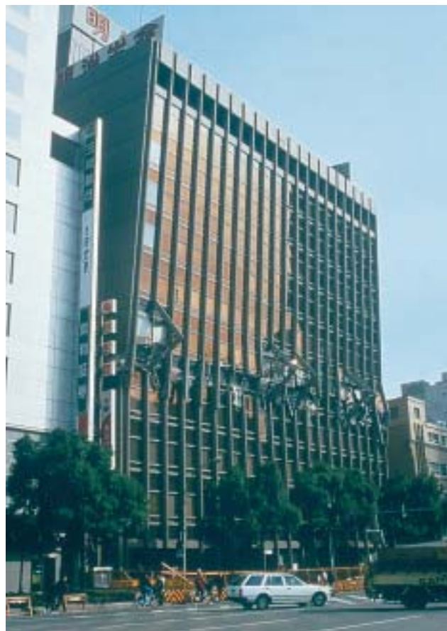
5/2 Un étage a également cédé dans cet immeuble de bureaux. La partie supérieure du bâtiment s'est affaissée en s'inclinant vers l'avant.
