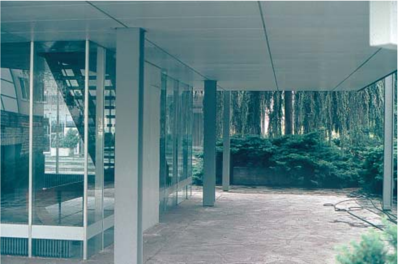
4/9 De tels bâtiments sont susceptibles de s'effondrer sous l'effet d'un tremblement de terre d'intensité modéré (Suisse, 2000).
