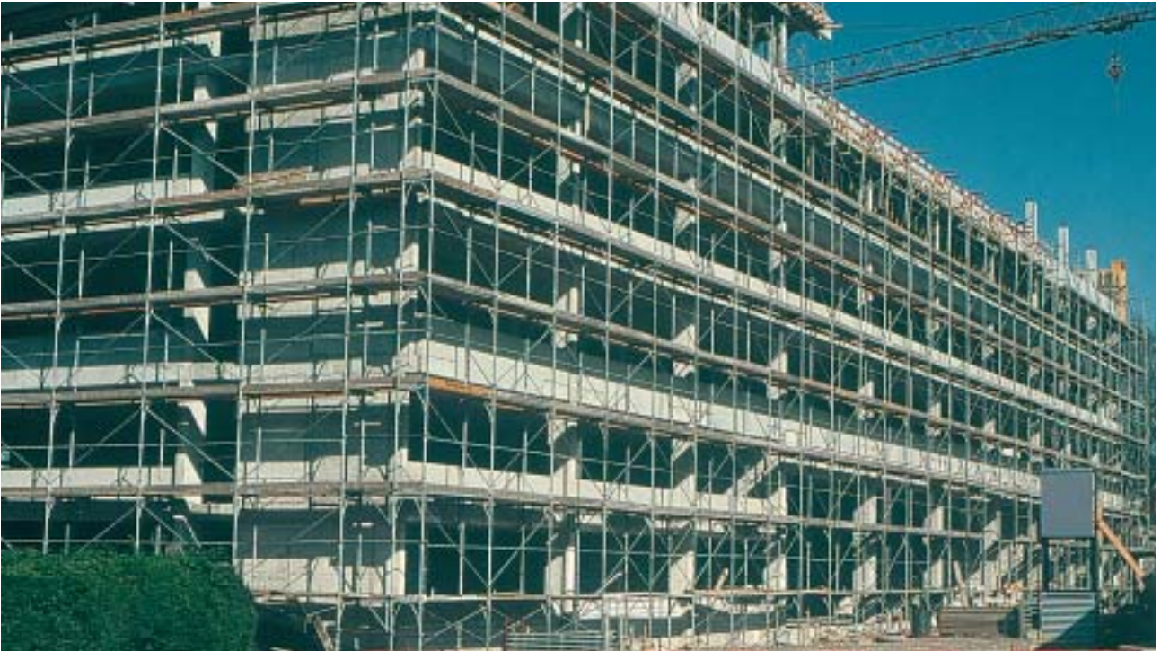
9/3 Deux angles de cette construction à ossature sont équipés de parois porteuses en béton armé reprenant les efforts transversaux.
