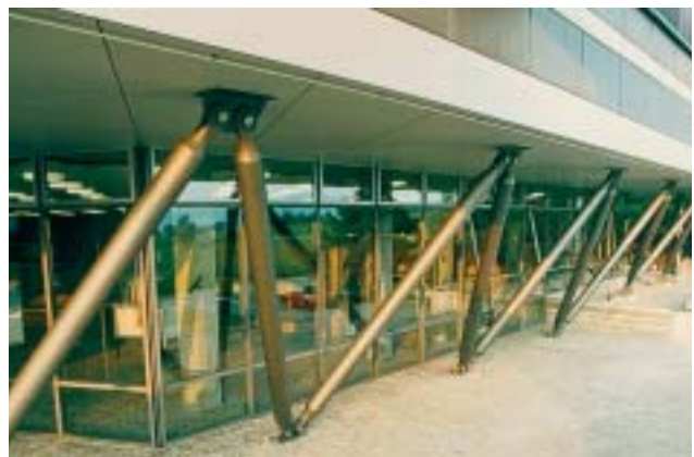
6/6 Le nouveau treillis en tubes d'acier s'insère dans le bâtiment existant sans en altérer l'esthétique.
