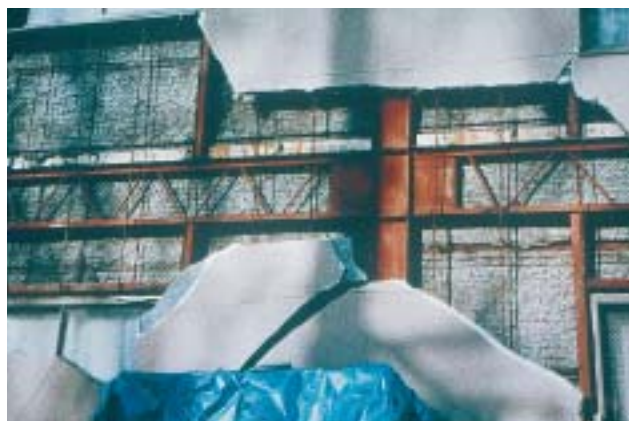
32/2 Ces plaques en béton léger, qui revêtaient une structure en acier ayant subi des dégâts mineurs, ont également été détruites (Kobe, Japon, 1995).
