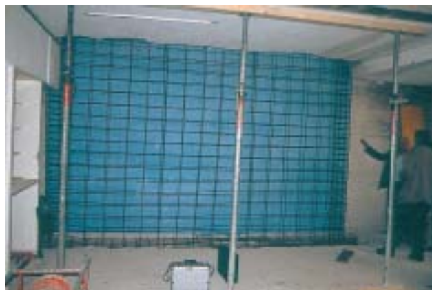
9/2 L'armature des parois porteuses en béton armé est relativement simple, mais elle doit être conçue et disposée avec grand soin. La figure présente une paroi ductile dimensionnée en capacité, de section rectangulaire, qui a été rajoutée dans un bâtiment existant (Suisse, 1999).
