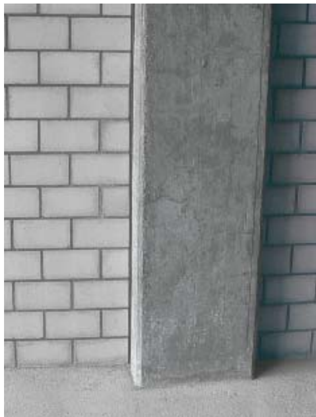
15/1 Ici, la paroi en maçonnerie et la colonne en béton armé sont séparées par un joint vertical, certainement beaucoup trop mince (Suisse, 1994).
