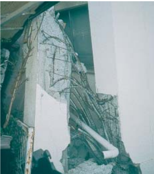
4/6 ... et voici les restes de la colonne d'angle avant-gauche du rez-de-chaussée
