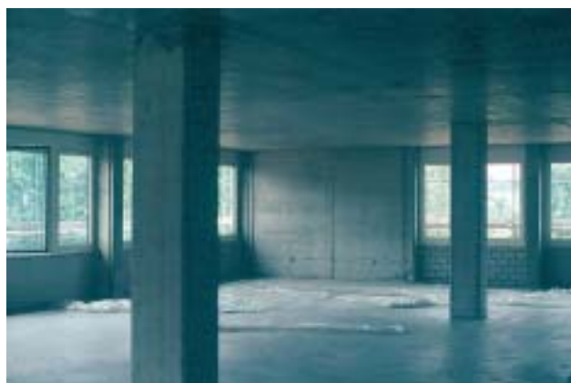
9/1 De telles parois porteuses en béton armé n'occupent qu'une place modeste en section et en élévation (Suisse, 1994).
