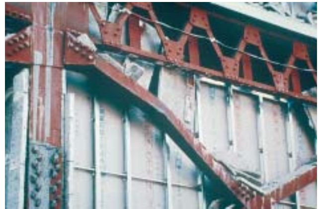
18/1 Des barres diagonales à larges ailes ont flambé selon leur axe de faiblesse...
