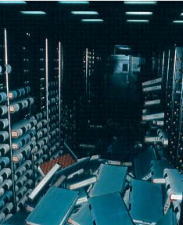
35/5 Des rayons de bibliothèque ouverts se vident à chaque tremblement de terre de forte intensité. On peut retenir les livres précieux en prévoyant des tabliers inclinés vers l'arrière ou des barres d'arrêt sur le devant (Loma Prieta, Californie, 1989).
