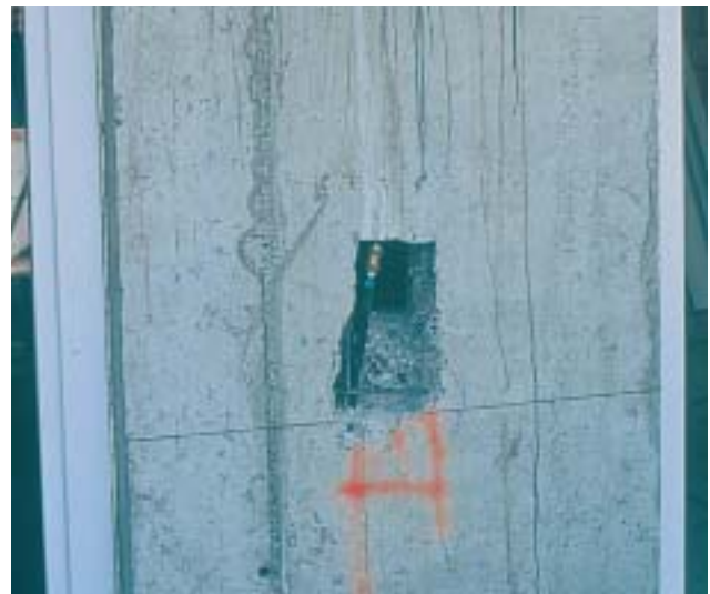
26/6 Dans certaines conditions, il est autorisé de pratiquer une ouverture dans une zone élastique d'un élément essentiel de la structure porteuse (ici une paroi porteuse élancée en béton armé), mais il est impérativement nécessaire de le faire en accord avec l'ingénieur (Suisse, 2001).
