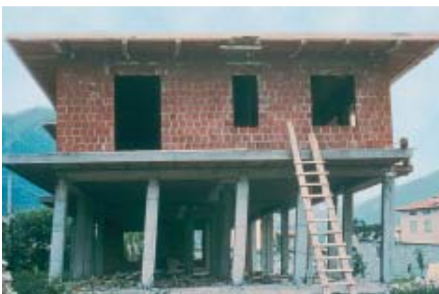
4/1 Le mécanisme de colonnes ayant affecté le rez-de-chaussée de ce bâtiment en construction a failli provoquer son effondrement (Frioul, Italie, 1976).
