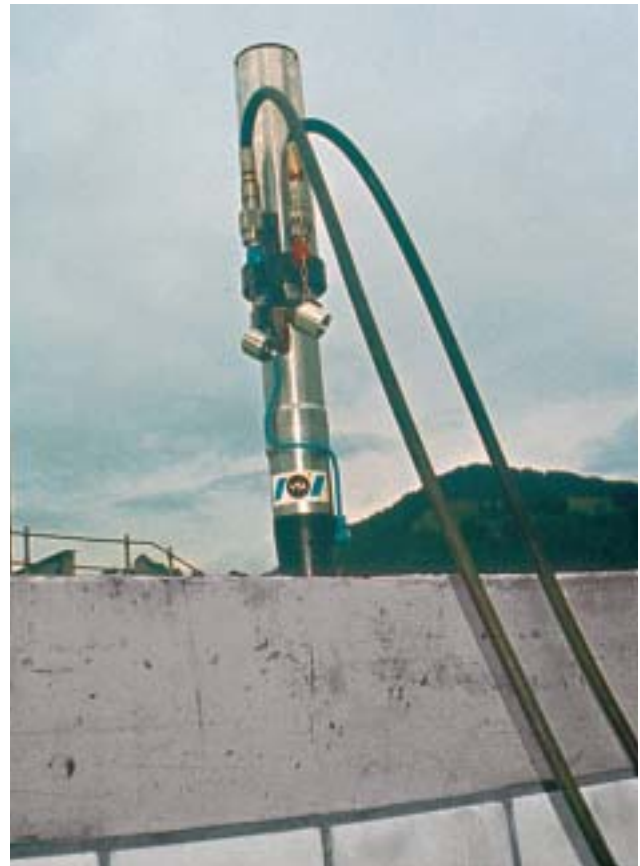
13/4 13/5 Lorsque l'on exerce une précontrainte verticale, la force normale ainsi générée permet d'améliorer notablement le comportement des parois en maçonnerie soumises aux tremblements de terre (Suisse, 1996).
