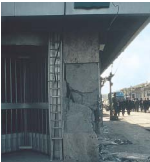
16/2 Les piliers en maçonnerie au rez-de-chaussée de ce restaurant ont fonctionné comme des colonnes courtes. Ils ont été gravement endommagés par des fissures obliques (Ombrie, Italie, 1997).
