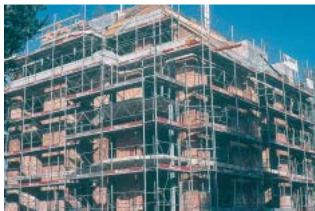
12/1 De tels bâtiments en maçonnerie – et même de moins hauts – sont extrêmement sensibles aux tremblements de terre s'ils ne sont pas renforcés par des parois porteuses en béton armé (Suisse, 2001).
