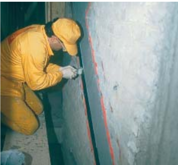
13/7 Les lamelles doivent être soigneusement collées et ancrées dans les dalles (Suisse, 1997).
